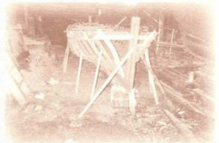
"A Fanequeira" en fase de construción
